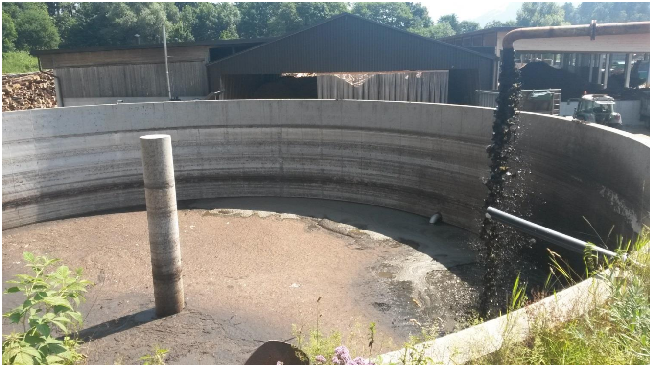
Güllebehälter mit Füllstand und eingeschalteter Umwälzpumpe.
